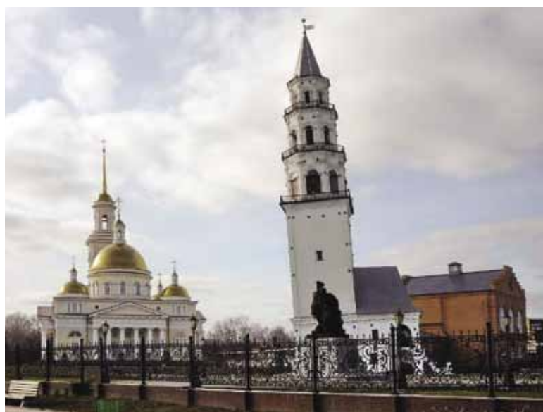
Невьянск, Демидовская «падающая» башня и Спасо-Преображенский собор. Символ Невьянска — Наклонная башня — является памятником архитектуры первой половины XVIII века (1725 г.). Наклон башня получила в процессе строительства из-за просадки грунта под основанием. Объект имеет статус историко-архитектурного памятника федерального значения.
